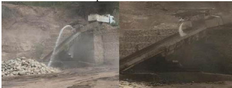
FOTOGRAFÍA NRO. 4 VISTA PARCIAL DE LA CRIBA PARA CLASIFICACIÓN PRIMARIA FUENTE: EQUIPO TÉCNICO CONSULTOR
